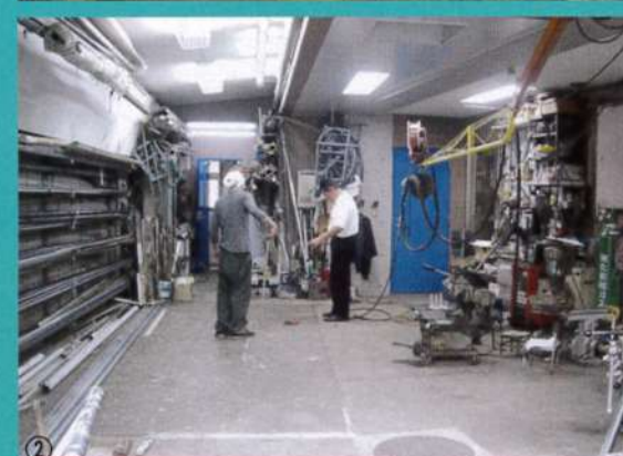
①オフィス風景 ②工場での作業風景 ③組立て中のテントの鉄筋骨組
